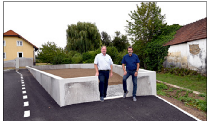
Durch die deutliche Verbreiterung des Durchlasses und die Absenkung der Straße um 25 cm ist der Bereich nun wirksam vor Starkregen geschützt.
