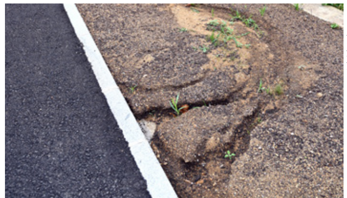
Die sichtbaren Spuren im Kies-Erde-Gemisch zeigen bereits deutlich, dass das Wasser in die gewünschte Richtung abbiegt.
