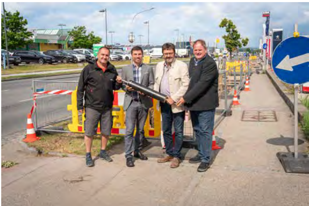
Netz NÖ Bauleiter Werner Schönhacker, EVN Wärme Projektleiter Markus Goldsteiner, Bgm. Gerhard Lentschig und Verkehrsstadtrat Manfred Daniel (v. l.) bei der Baustelle in der Prager Straße. Foto: Anton Ettl
