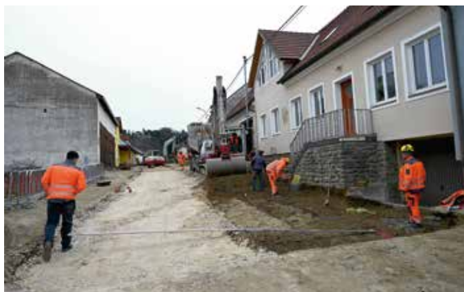
Die Durchfahrtsstraße durch Doberndorf soll bald asphaltiert werden. Gerade laufen noch die letzten Bauarbeiten und der Aufbau des Straßenunterbaues.
