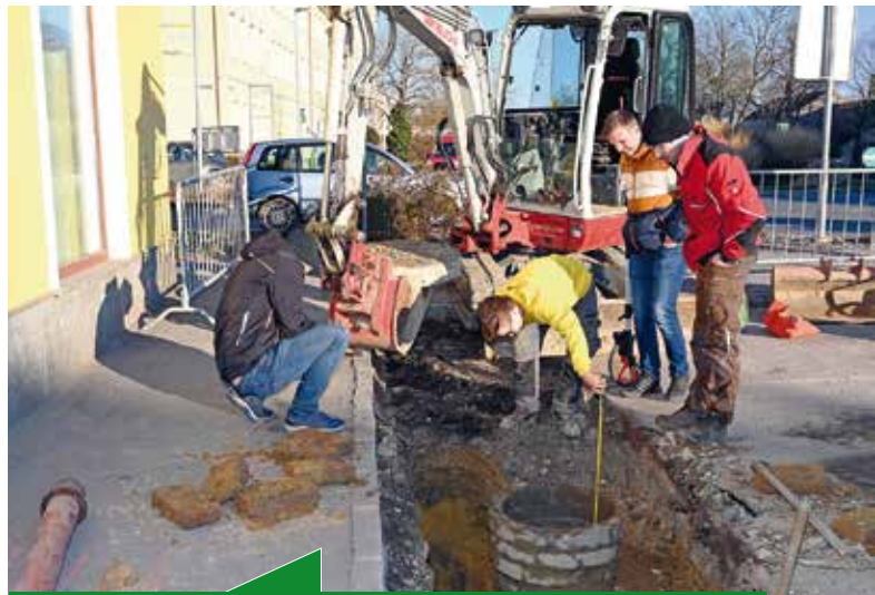
Der geöffnete Kanal wird von Jonas Bauer (2. v. l.) überprüft. Am Bild: Lukas Heimberger, Jonas Bauer, Gregor Hiemetzberger und David Strohmmer (v. l.).
